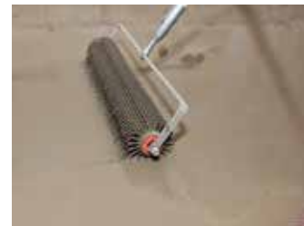
6. Abschließend das Material mit einer Stachelwalze entlüften
