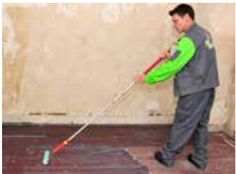
2. Grundierung mit KÖSTER VAP I 06
