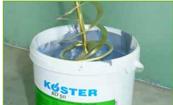
Zunächst wird KÖSTER BD 50 aufgemischt. Dazu ist ein langsam laufendes elektrisches Rührwerk (400 U / min.) zu empfehlen, mit dem das Material im Eimer ca. 1 Minute gerührt wird.
