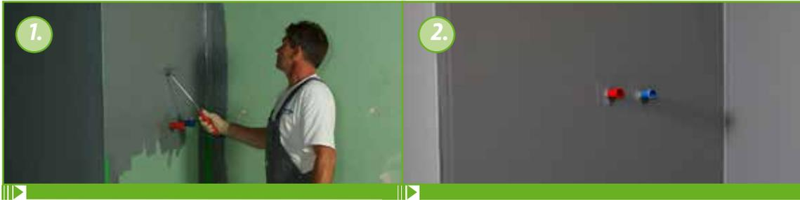
KÖSTER BD 50 wird mit Hilfe eines Pinsels oder Rollers aufgebracht. Abdichtungen werden immer in mindestens zwei Lagen aufgebracht. Der Verbrauch pro Lage beträgt ca. 0,5 bis 0,6 kg / m<sup>2</sup> was zu einem Gesamtverbrauch von ca. 1 bis 1,2 kg / m<sup>2</sup> führt. Die Wartezeit zwischen den einzelnen Lagen beträgt mindestens 3 Stunden.
