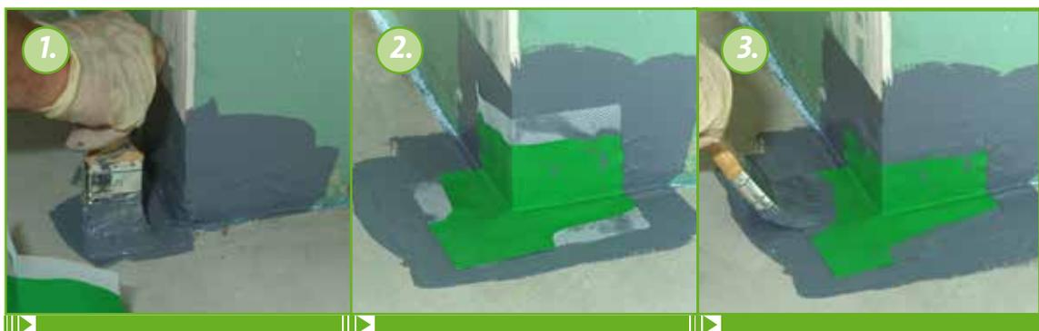
1. Die Ecke wird zunächst mit einer Schicht KÖSTER BD 50 vorbereitet, die ca. 10 cm der Wand und 10 cm des Bodens bedecken sollte.
