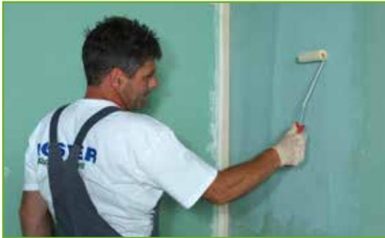
KÖSTER BD 50 Voranstrich wird mit einem Pinsel oder Roller auf den Untergrund aufgebracht. Der Verbrauch variiert je nach Art des Untergrundes. Um eine Gipskartonplatte zu grundieren, wird KÖSTER BD 50 Voranstrich im Verhältnis 1:3 mit Wasser verdünnt. Der Verbrauch dieser Mischung beträgt ca. 240 g/m<sup>2</sup>. Genauere Informationen über weitere Untergründe stehen im technischen Merkblatt.
