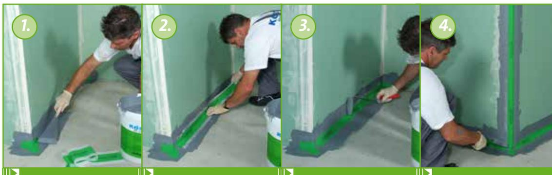
Die Fläche entlang des Wand-Sohle-Übergangs wird mit einer Schicht KÖSTER BD 50 vorbereitet, die ca. 10 cm der Wand und 10 cm des Bodens bedecken sollte.
