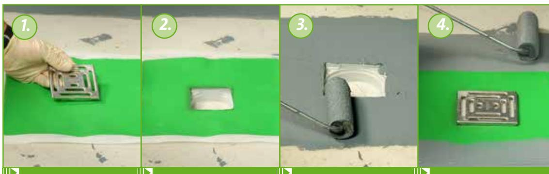
Die KÖSTER BD Bodenmanschette wird über dem Bodenablauf positioniert.
