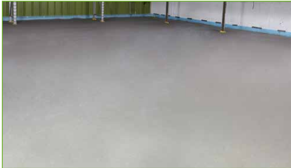
Das Ergebnis: ein schnell und sicher ausgeführter dauerhafter Bodenausgleich
